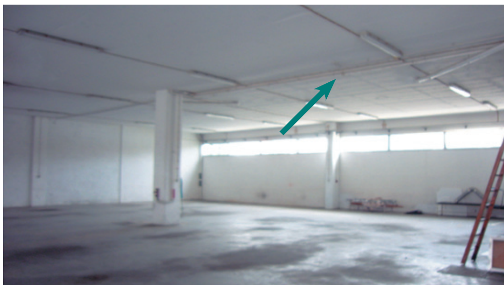
Figura 2 – Laje deformada resultante de um erro de projecto.
